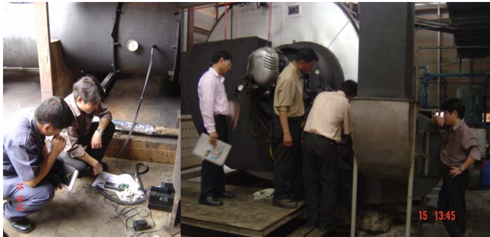
รูปที่ 3-7 การใช้เครื่องมือตรวจวัดก๊าซไอเสีย
