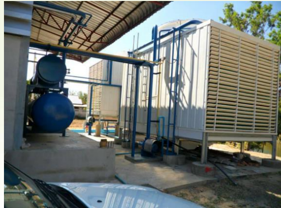
การปรับปรุงระบบหล่อเย็นและต่อท่อเพื่อนำน้ำไปใช้ยังระบบบำบัดกลิ่น (หลังการดำเนินการแผนงาน)
