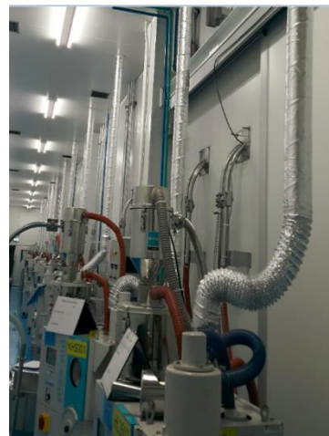
หุ้มฉนวนกันความร้อน (ฟรอยด์) (หลังดำเนินการ)
