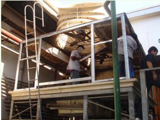
การปรับปรุงระบบหล่อเย็นและต่อท่อเพื่อนำน้ำไปใช้ยังระบบบำบัดกลิ่น (หลังการดำเนินการแผนงาน)
