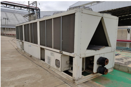
เครื่องทำน้ำเย็นชุดเดิมที่ใช้งาน
