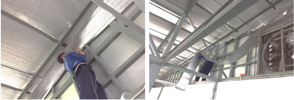
การติดตั้งฉนวนหลังคา
