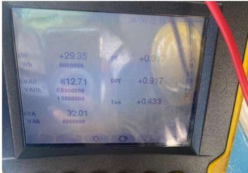
การตรวจวัดพลังงานไฟฟ้าปั๊ม RO
