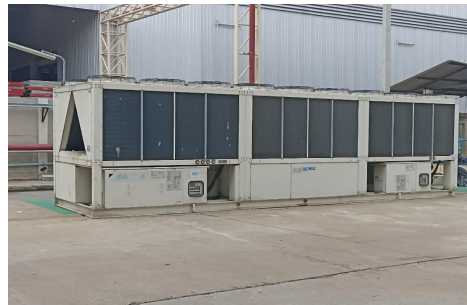
เครื่องทำน้ำเย็นชุดเดิมที่ใช้งาน
