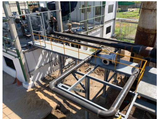
หลังปรับปรุง การเปลี่ยนกับดักไอน้ำและซ่อมแซมรอยรั่วไอน้ำ
