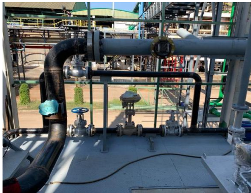
หลังปรับปรุง การเปลี่ยนกับดักไอน้ำและซ่อมแซมรอยรั่วไอน้ำ
