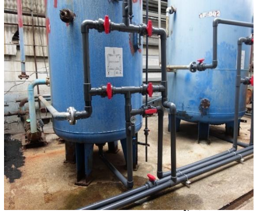
หลังปรับปรุงทำการซ่อมแซมน้ำรั่วไหล
