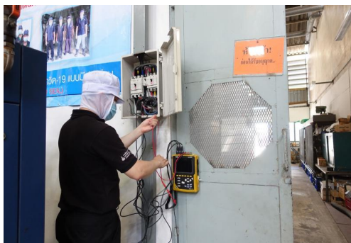
การตรวจวัดพลังงานไฟฟ้าเครื่องอัดอากาศ
