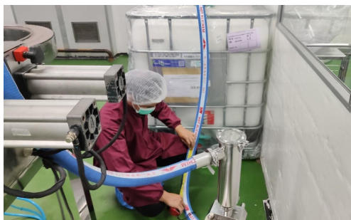
การติดตั้ง Ball Pump
