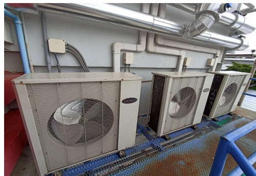
คอยล์ร้อนของเครื่องปรับอากาศ
