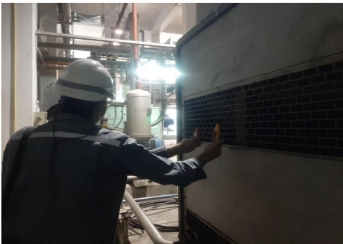
การตรวจวัดอุณหภูมิอากาศเข้าเครื่องอัดอากาศ และบริเวณโดยรอบของห้อง
